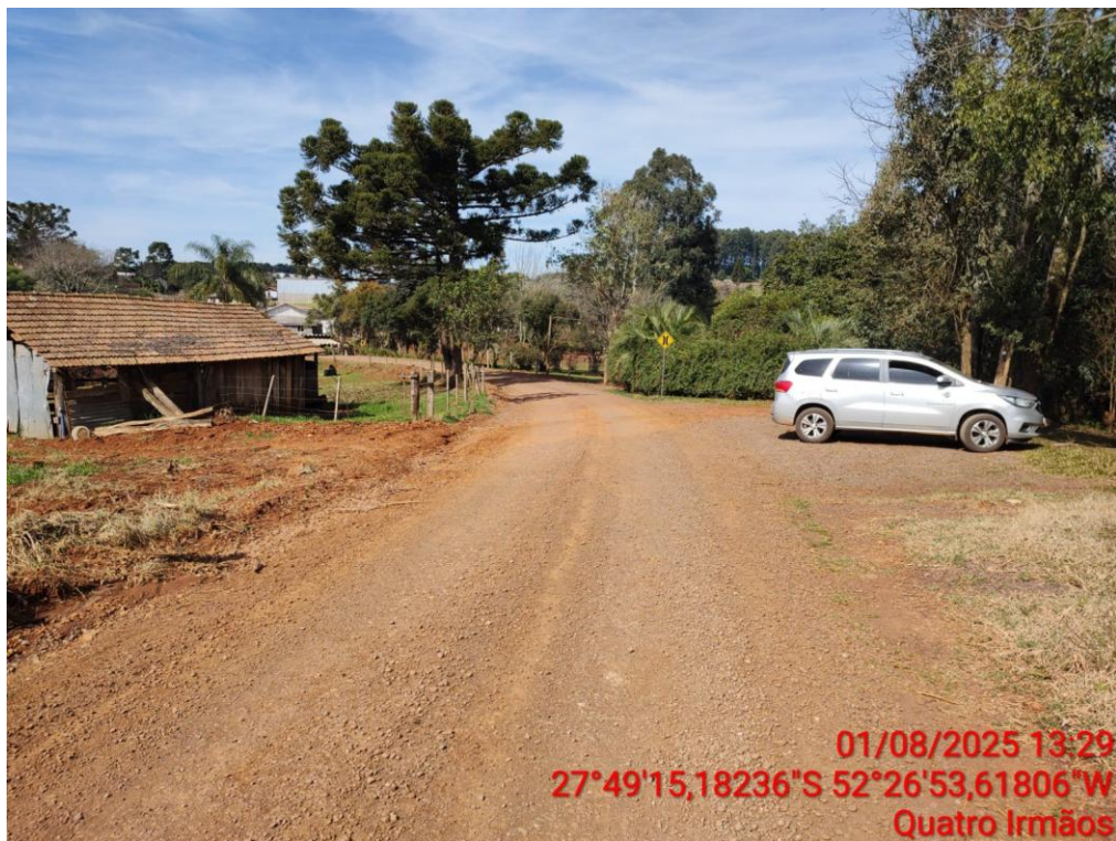
Pavimentação em CBUQ – Trecho 02
