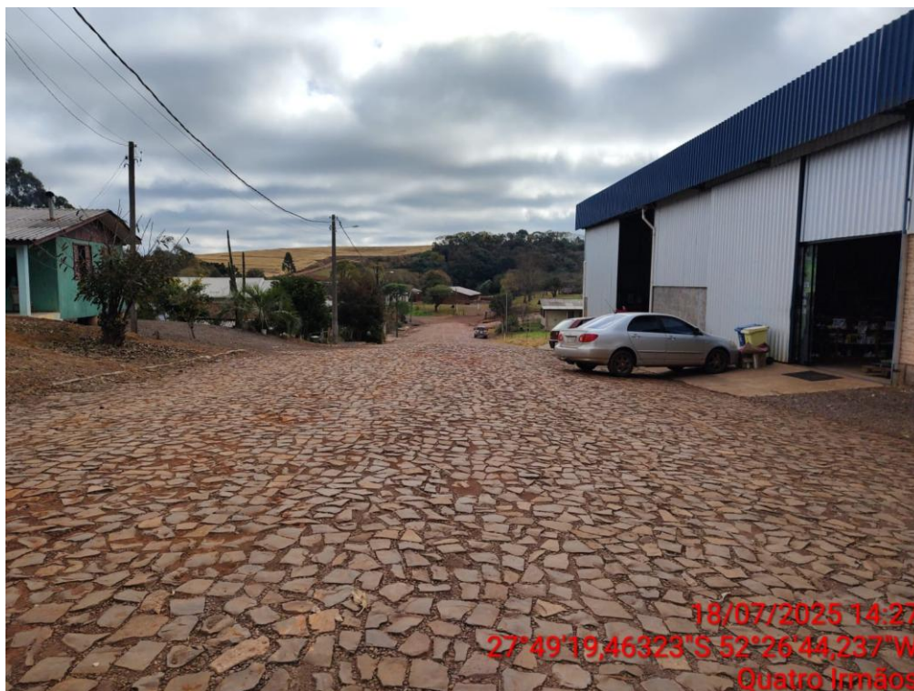
Pavimentação em CBUQ – Trecho 01
