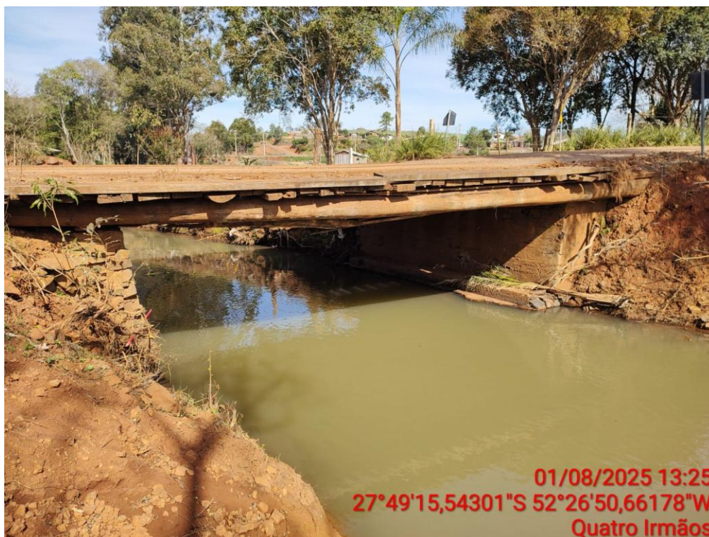
Ponte à ser substituída
