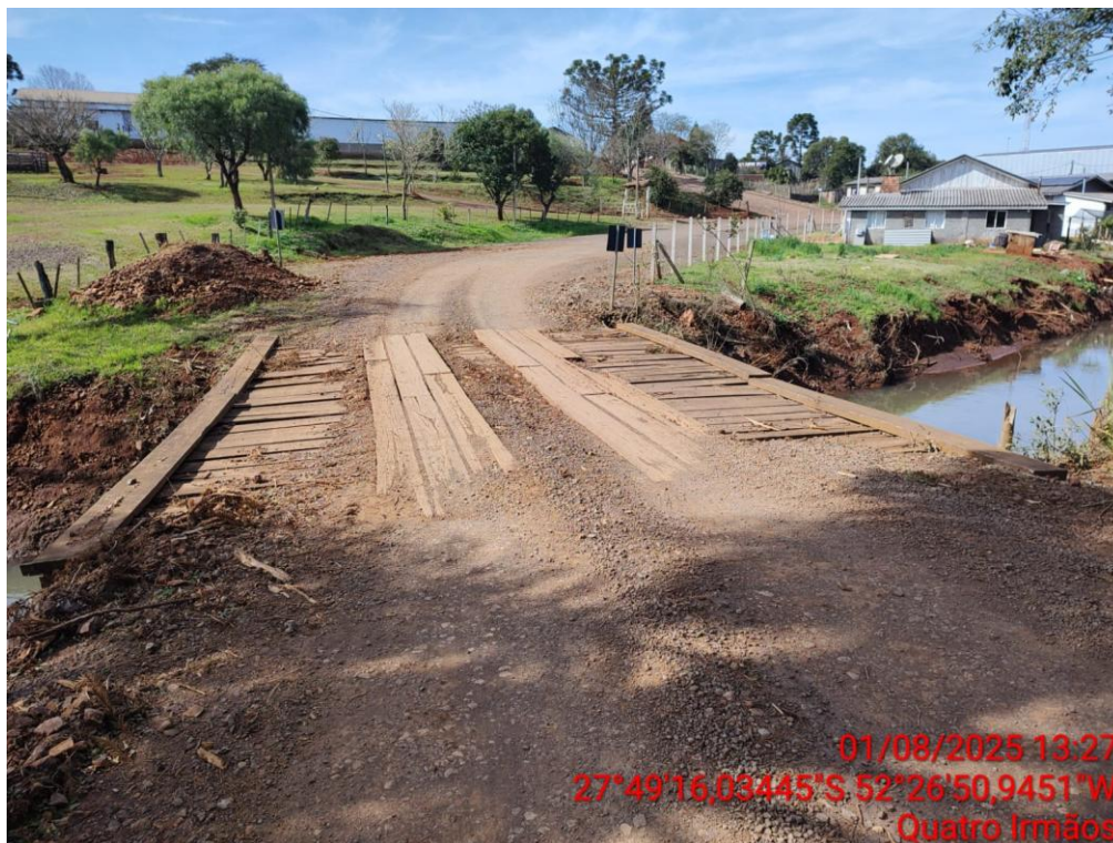
Ponte à ser substituída
