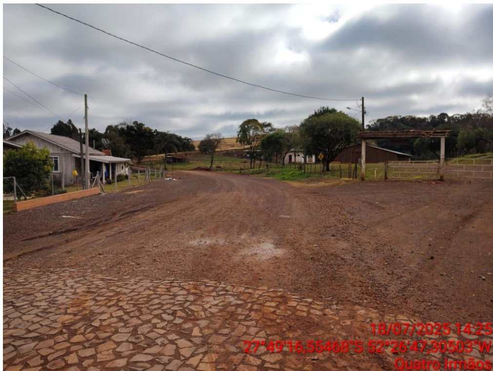
Pavimentação em CBUQ – Trecho 02
